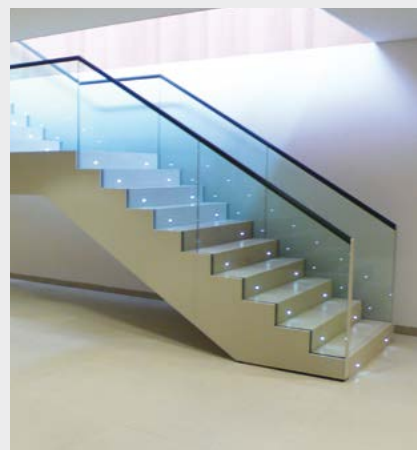
Kunstmuseum, Eingangsbereich. Frühhochfeste Klebe- und Fugenmörtel unter großformatigen Betonwerksteinbelägen.
