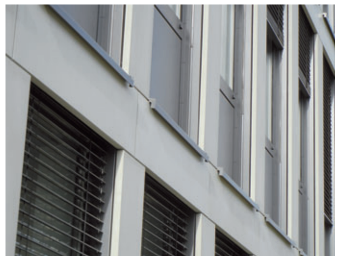
Bürogebäude Ferchau, Fugenausbildung
