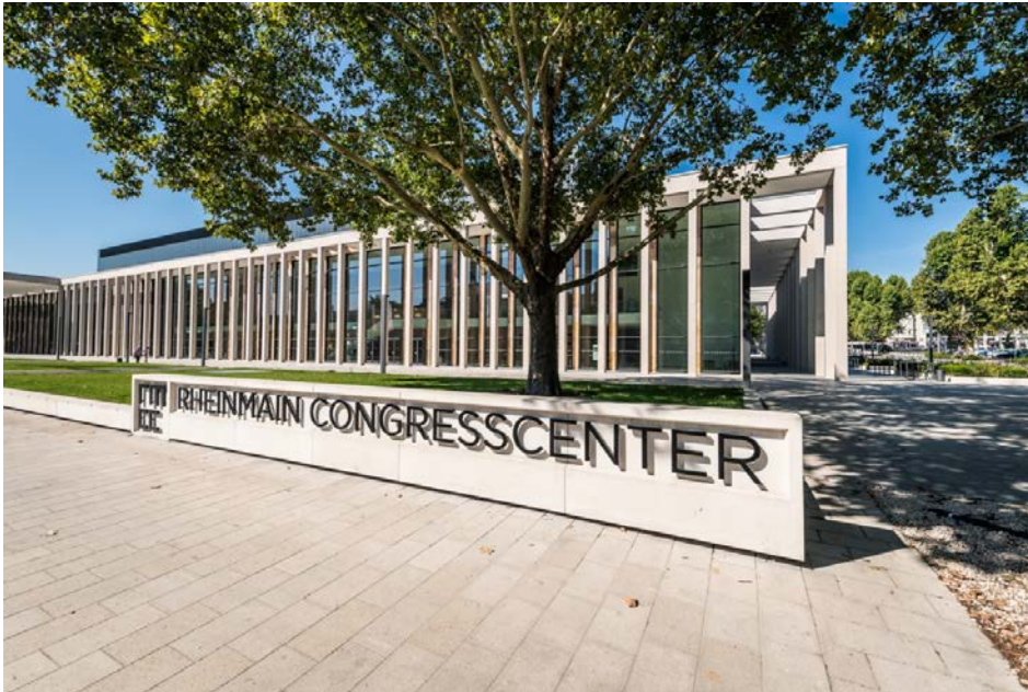
Das Wiesbadener RheinMain CongressCenter mit einer Kolonnade aus edlen Sichtbetonstützen.
