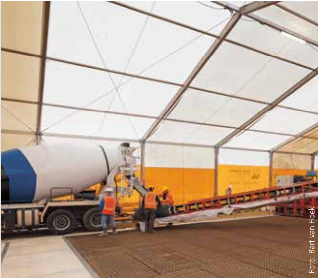
Der eigens entwickelte Einbaufertiger kann auf einer Breite von 12 m in einem Zug einbauen.
