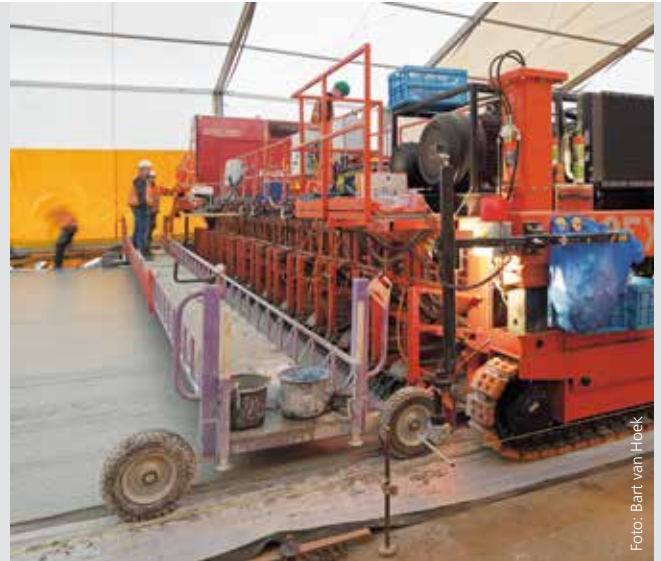
An einem Tag können 100 m Brückendecke gefertigt werden.
