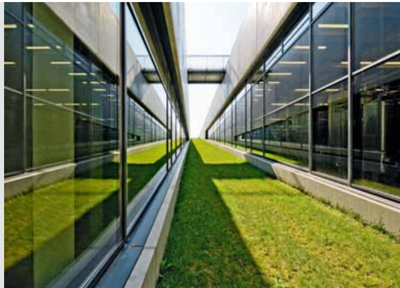
Über die „Lichtfuge“ gelangt Tageslicht durch große Fensteröffnungen in angrenzende Keller. Konstruktion aus vorgefertigten, großformatigen Sichtbetonelementen, ebenfalls schalungsglatt SB3
