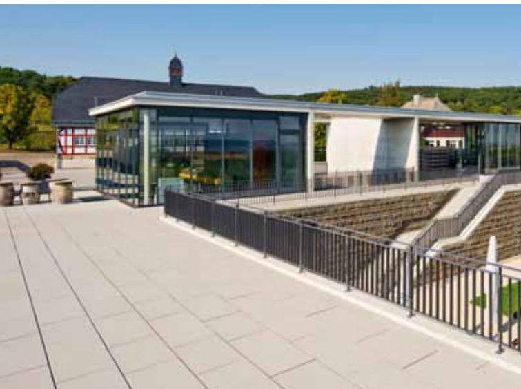
Panoramaterrasse und Treppenanlage: Großformate mit gestrahlter Oberflächenoptik aus Dyckerhoff Weisszement.
