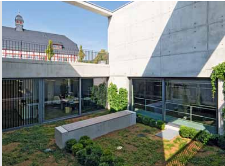
Innenhof, über den ebenfalls Tageslicht in die Keller und Büros gelangt. Konstruktion aus Transportbeton, schalungsglatt SB3.
