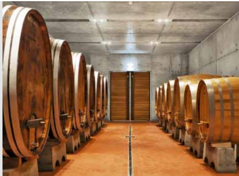
Blick in den Holzfasskeller: Wände und Decken in schalungsglattem Sichtbeton.
