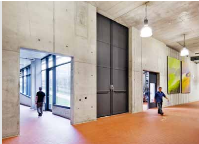
Basiskeller für Weinlagerung und Abfüllung. Wände und Decken in schalungsglattem Sichtbeton.
