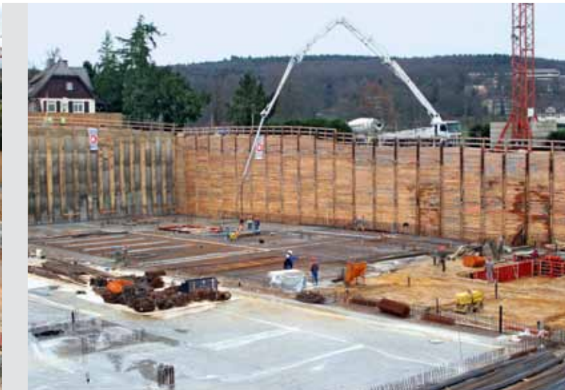
Blick in die Baugrube: Betonage der Bodenplatten.
