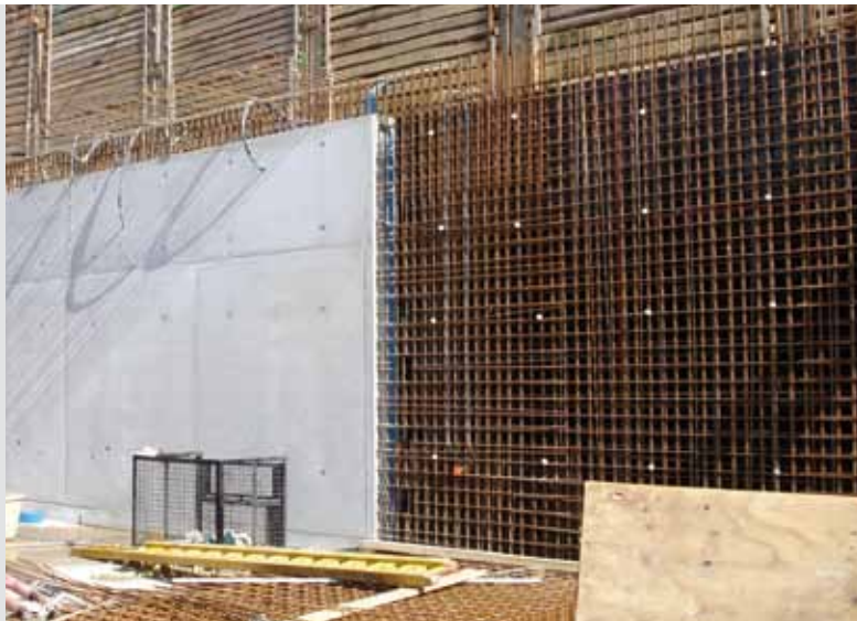
Erste Sichtbetonwände nach dem Ausschalen.
