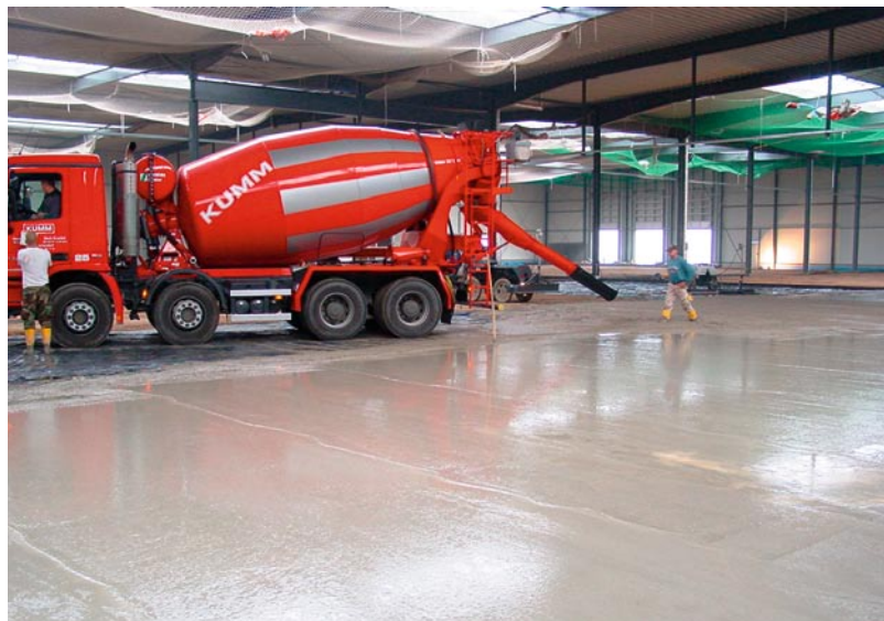
Anlieferung des Betons
