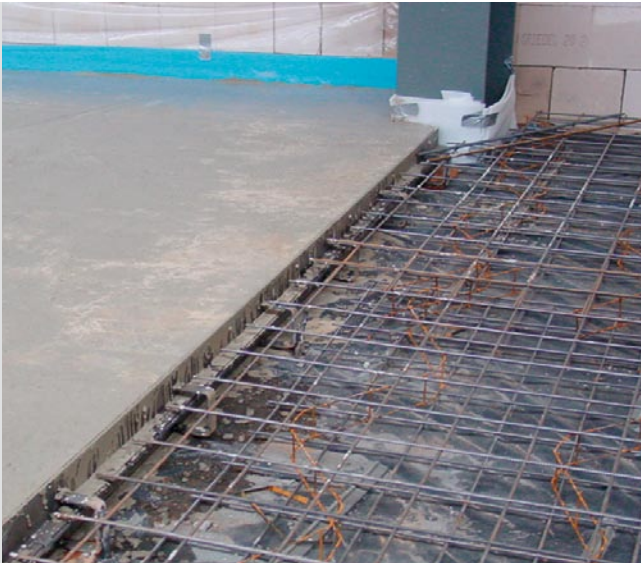
Bewehrung im Randbereich der Platten
