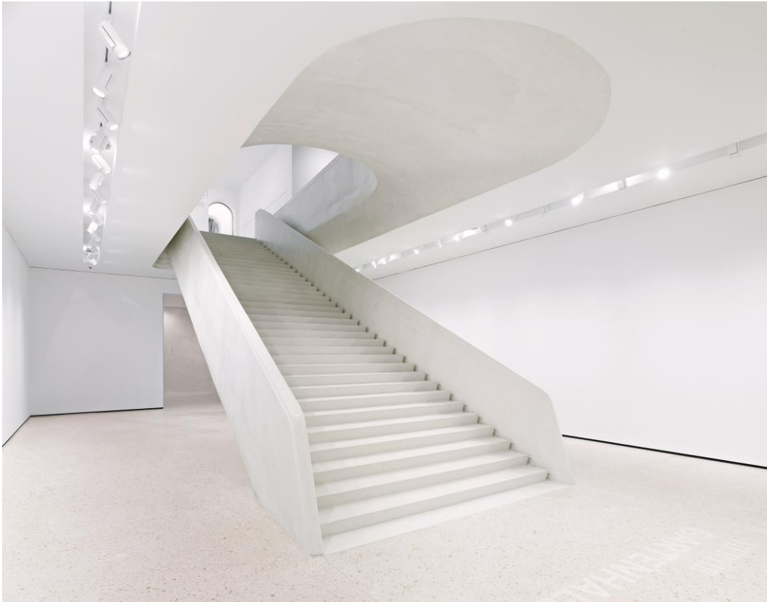
Beispiel: Fugenloser Boden aus Dyckerhoff Terraplan, hier: Städel-Museum in Frankfurt (Foto Norbert Miguletz)
