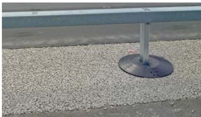
Nutzfläche mit REWADUR Bankettbeton
