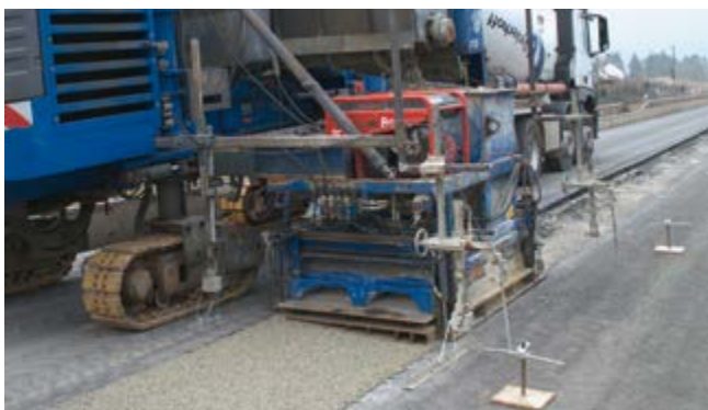
Einbau von REWADUR Bankettbeton
