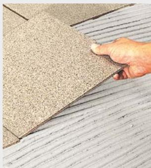
Die Anwendungen zeigen die gute Verarbeitung von Klebern auf Basis von Dyckerhoff Weiss CONTACT an Wand und Boden, wie auch als Fugenmaterial z. B. im Sanitärbereich (s.o.).
