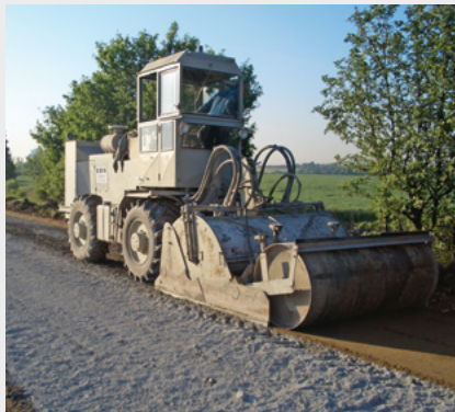
Planieren nach dem Einfräsen
