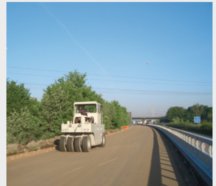
Verdichten des Planums
