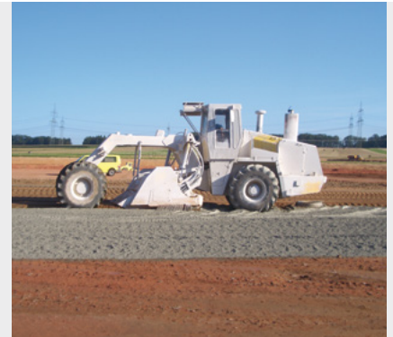
Einfräsen von Dyckerhoff VARILITH
