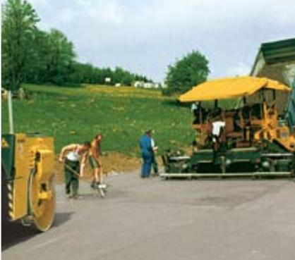
Einbau und Verdichtung einer Hydraulisch Gebundenen Tragschicht (HGT)
