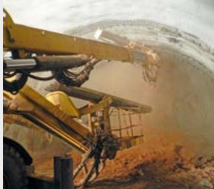
Gewölbesicherung mit Spritzbeton
