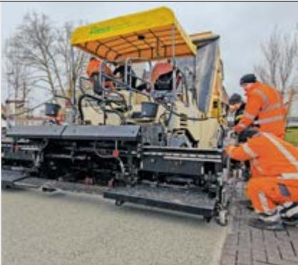
Einbau Dränbeton mit Fertiger
