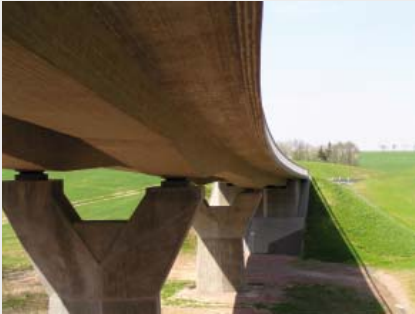
Brücke im Zuge der B 180n bei Hettstedt BW 3a
