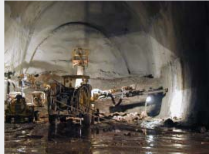
Lafettenbohrer im Einsatz
