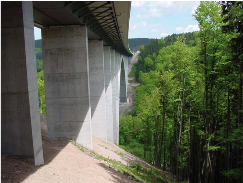
Talbrücke „Wilde Gera“ mit CEM II/B-S 32,5 R, Baujahr: 2001, Betonmenge: 18.000 m 3
