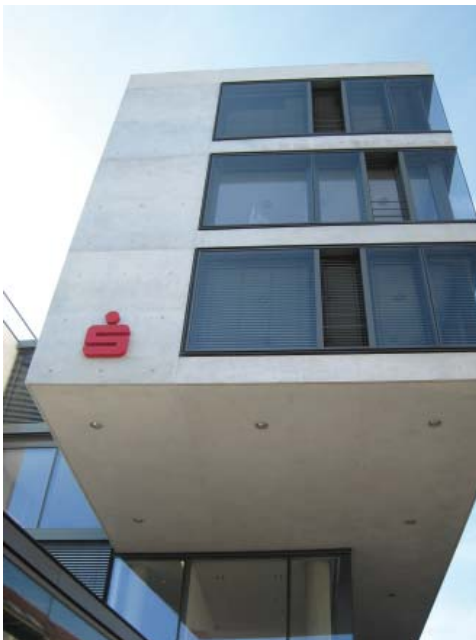
Sparkasse Ulm, Fassade und Teile der Innenräume als Sichtbeton mit CEM II/A-LL 32,5 R, Bauzeit: 2005/2006, Betonmenge: 2.100 m 3
