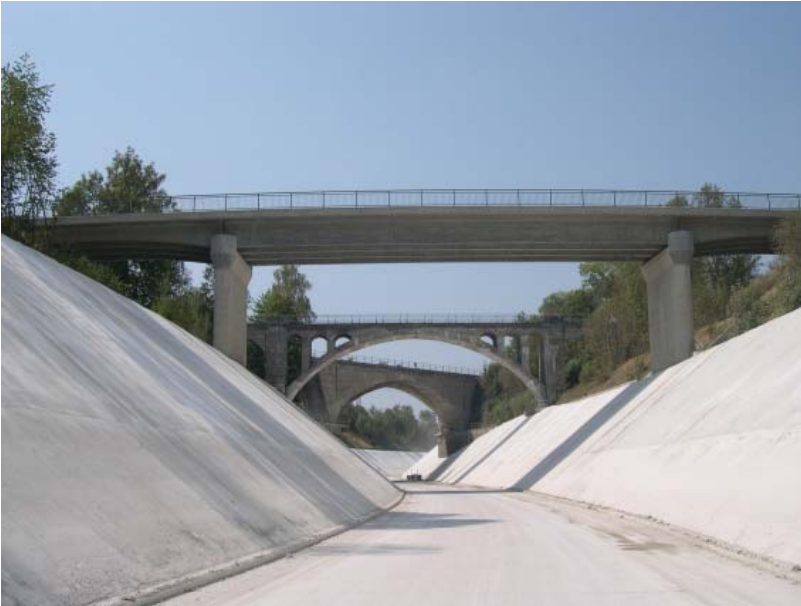
Inn-Kanal-Sanierung, Kanalseitenflächen und Sohlen mit CEM II/B-S 32,5 R, Baujahr: 2003, Betonmenge: 150.000 m 3
