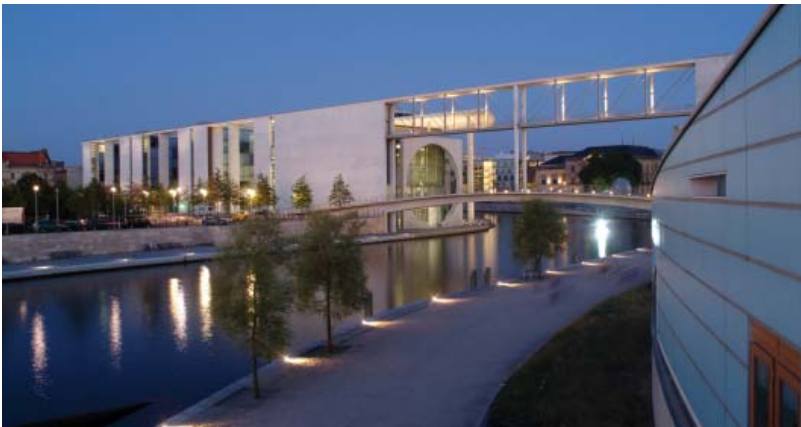
Bundesbauten am Spreebogen in Berlin, Bodenplatten und Sichtbetonwände mit CEM III/A 32,5 N, Bauzeit: 1996 – 2001, Betonmenge: gesamt ca.100.000 m 3
