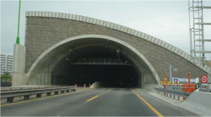
Einhausung der BAB A4 bei Jena, Fundament, Gewölbe und Kappen mit CEM II/B-M (S-LL) 32,5 R, Bauzeit: Beginn 2004, voraussichtliches Ende 2010, Betonmenge: 76.000 m 3
