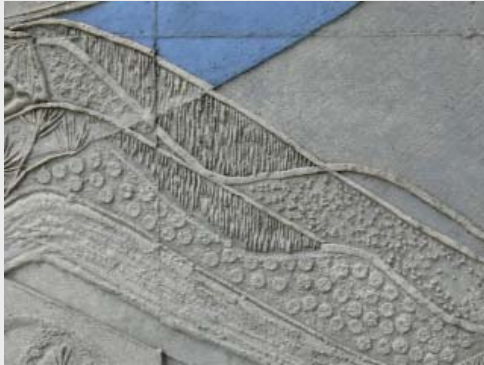
Betonrelief auf den Wandscheiben des Glockenturms. Aufnahme aus dem Jahr 2007.
