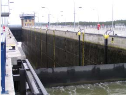
Blick in die Schleuse, Länge 190 m, Breite 12,50 m; Hubhöhe 18,55–19,05 m
