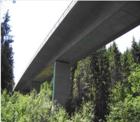
Mehrere Brücken im Zuge der B294 Umfahrung Freudenstadt bei Lauterbad in klimatisch exponierter Lage im Nordschwarzwald, Taktschiebeverfahren
