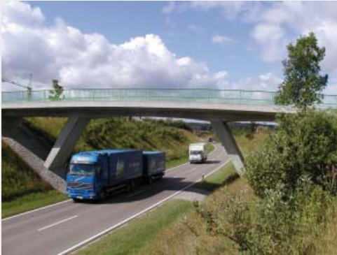
Brückenbauwerk zur Umfahrung der Stadt Merklingen, Überführung über die L 1230
