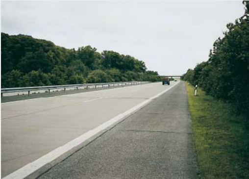
Betonfahrbahndecke Bundesautobahn BAB A29 zwischen Oldenburg und Wilhelmshaven
