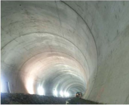
Tunnelröhre im Zuge der vierstreifigen L 418n
