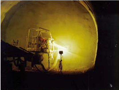
Spritzbetoneinbau (Nassspritzverfahren)
