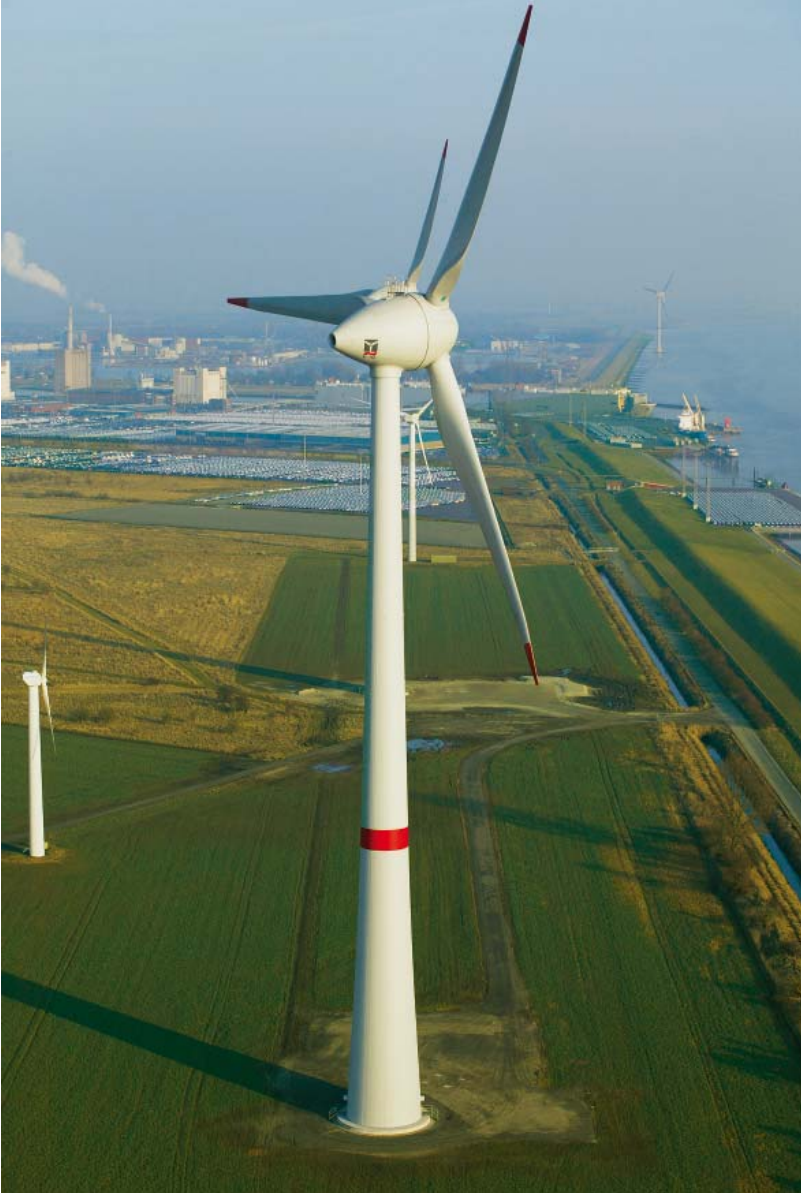
Windkraftanlage in Emden, Fundament und Mast mit CEM III/A 42,5 N, Bauzeit: 2003 – 2004, Betonmenge: 2000 m 3 je Anlage
