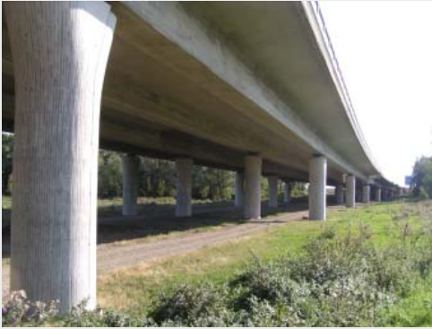
Brücke Neugattersleben im Zuge der BAB A14
