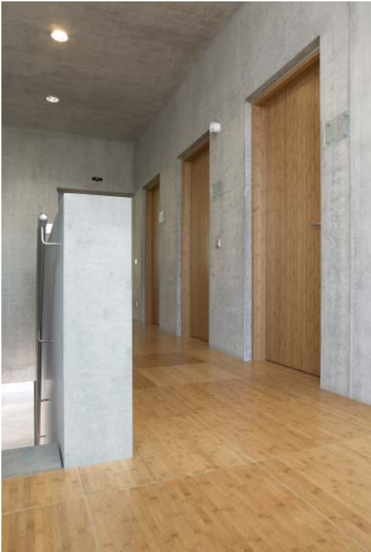
Zentraler Leitstand im Zementwerk Dotternhausen, Wände, Stützen und Decken mit CEM II/B-T 42,5 N, Baujahr: 2006, Betonmenge: 601 m 3
