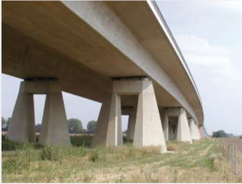
Saalebrücke Beesedau im Zuge der Bundesautobahn BAB A14 (Vorlandbrücke)
