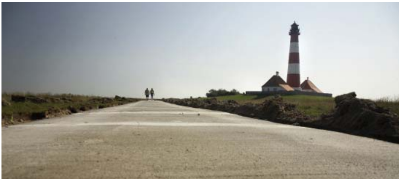
Fahrweg Westerhever mit CEM III/A 42,5 N-NA, Baujahr: 2006, Betonmenge: 600 m 3
