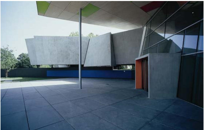
Freizeit- u. Thermalbad „TuWass“ in Tuttlingen, Wände, Stützen und Decken mit CEM II/B-T 32,5 R, Baujahr: 2001, Betonmenge: 4.200 m 3
