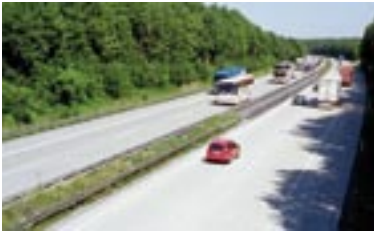
Bild 13: Betonfahrbahndecke mit CEM I-Zement (links) bzw. mit CEM III-Zement (rechts)
