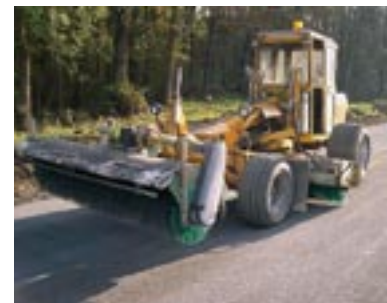
Bild 16: Ausbürsten des Oberflächenmörtels
