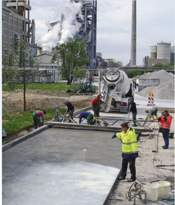
Bild 5: Betoneinbau und Aufsprühen des Verzögerers
