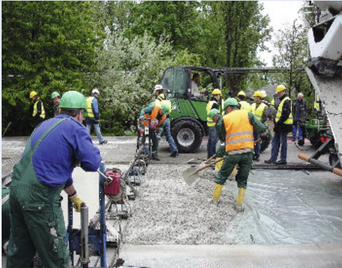
Bild 4: Betoneinbau auf PE-Trennfolie
