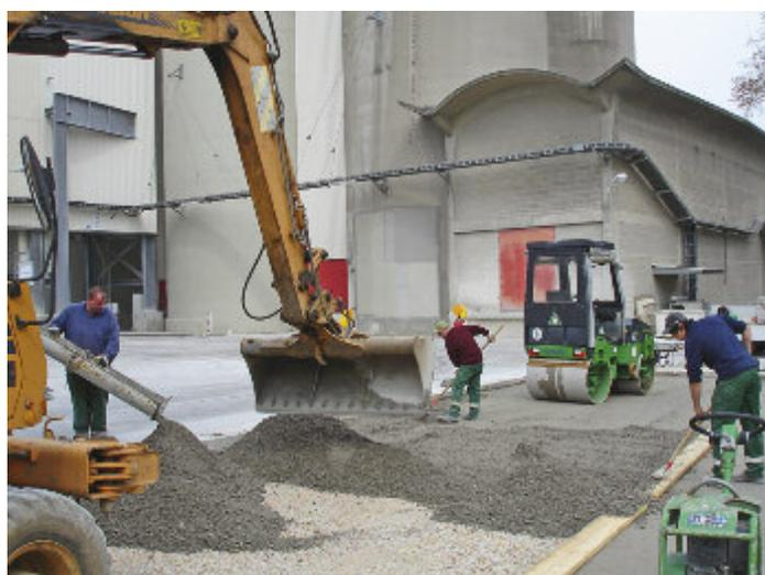
Bild 2: Einbau HGT bei der Erweiterung der Zufahrt zur Weisszementverladung
