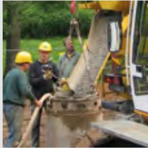
Einfüllen des Bohrpfahlbetons
