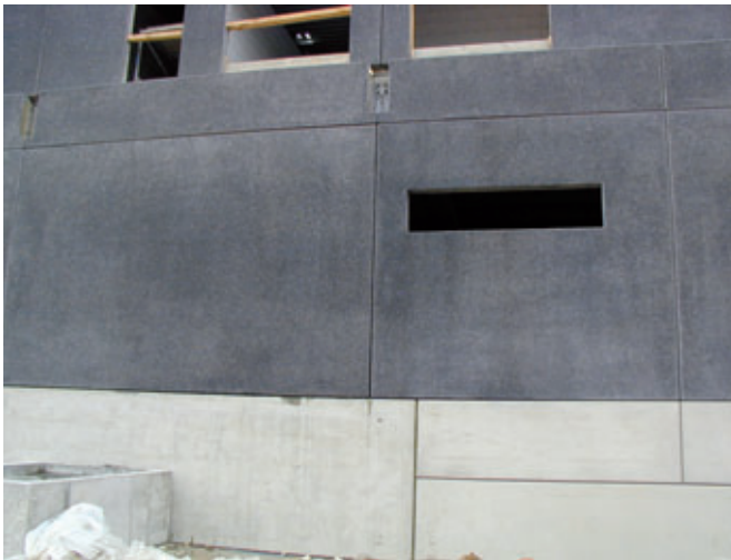
Ausgeblühte schwarze Fertigteile
