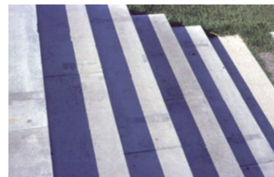
Lagerstreifen bei Blockstufen
