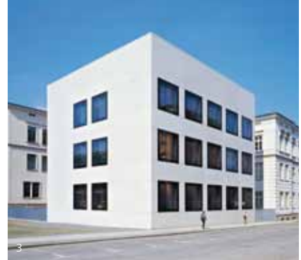
Schalungsglatte Betonfertigteile, Weißzement und gelber Sand, Universität, Leipzig
