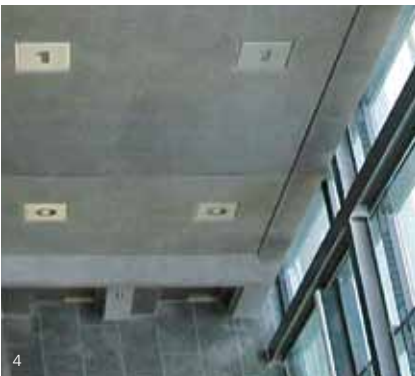
Aufzugschacht aus geschliffenem Beton, Büro- und Geschäftshaus, Frankfurt
