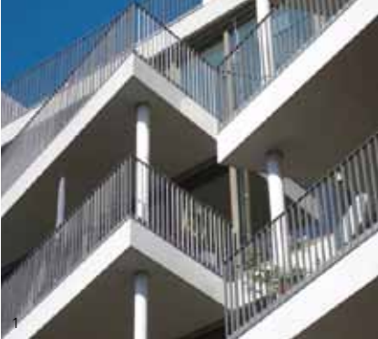
Balkone aus schalungsglattem Beton, Lofthaus, Berlin
