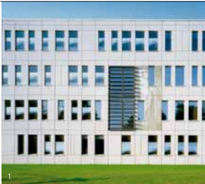
Fotobeton und gesäuerter Beton, Bürohaus, Mannheim
