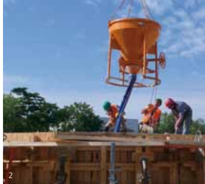
Betonieren mit Schlauch
