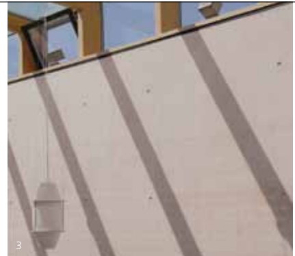
3 Schalungsglatter Beton, Weißzement und rötlicher Sand, Neue Mitte, Weiden
