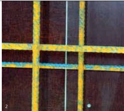
Abgedichteter Schalhautstoß
