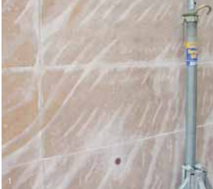
1 Falsche Nachbehandlung durch teilweise anliegende Folie
