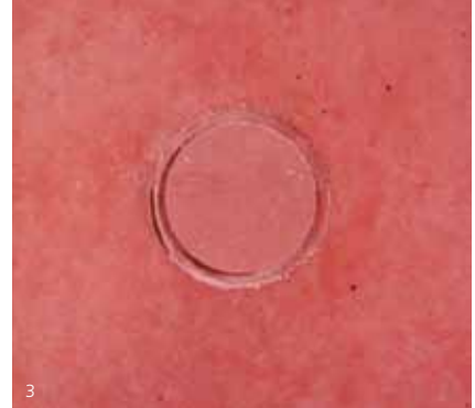
3 Faserbetonstopfen rot eingefärbt
