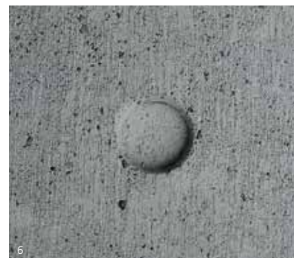
Scharrierter Beton, Konzerthaus, Freiburg
