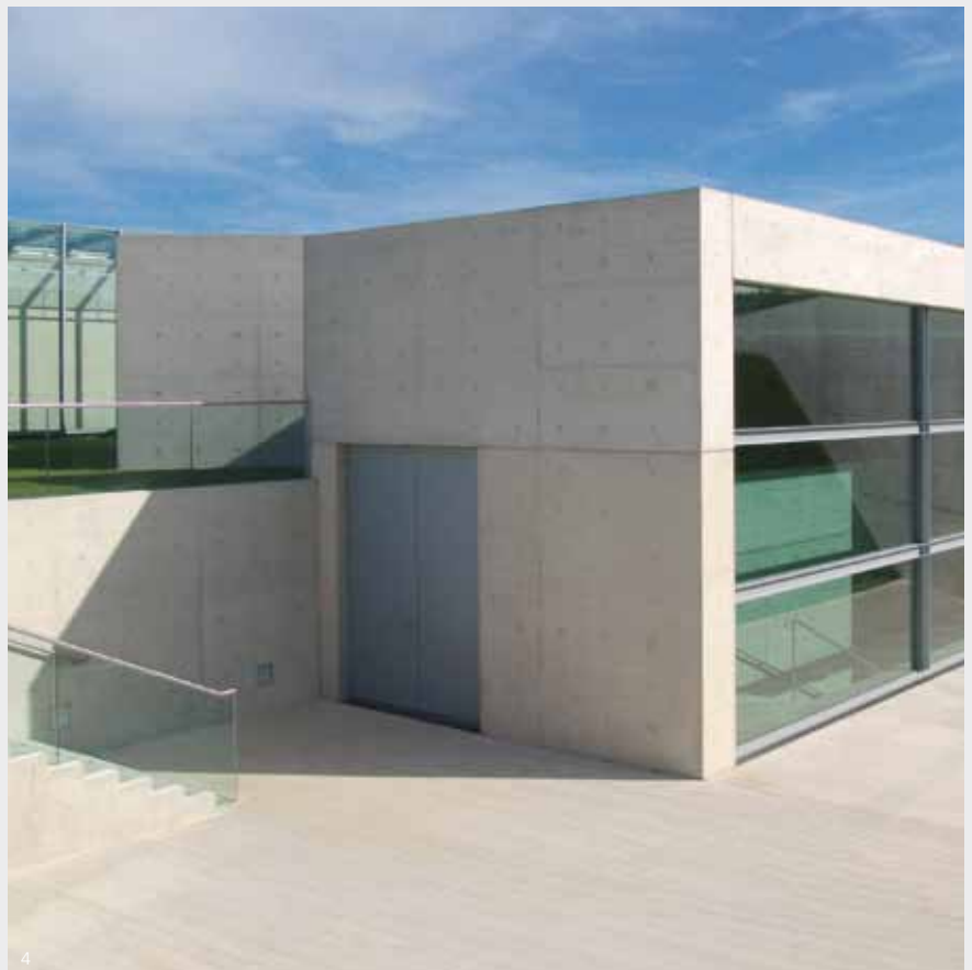
4 Selbstverdichtender Beton, Museum, Hombroich
