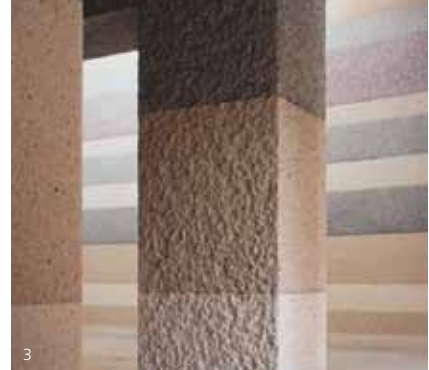
3 Gestockter und gespitzter Beton, Kirche, Köln
