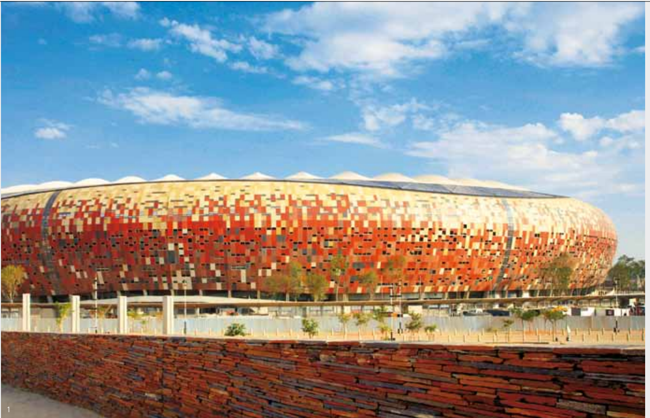
1 Eingefärbte Faserbetonplatten, Fußballstadion, Südafrika
