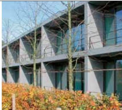
Gesäuerter Beton, Bürogebäude, Coesfeld
