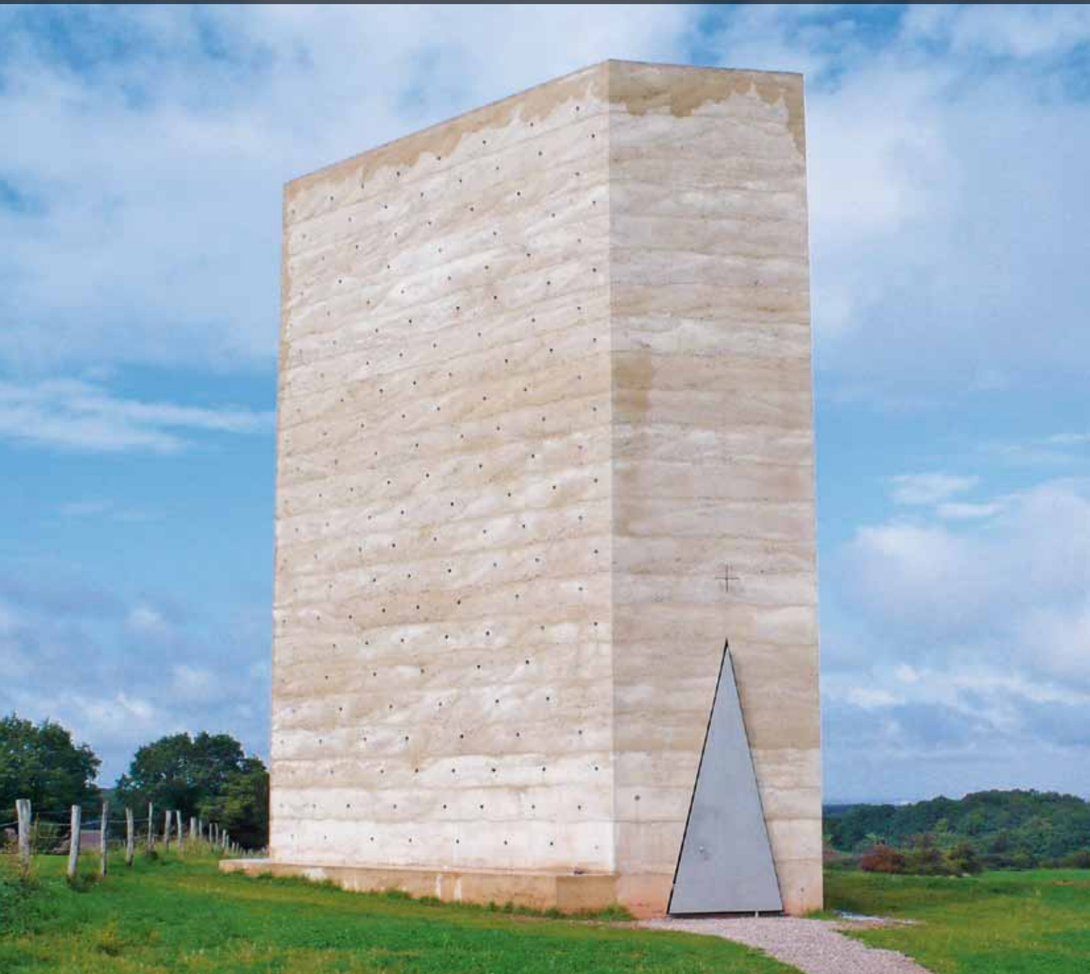
Sichtbeton mit Dyckerhoff WEISS Planung und Ausführung von Sichtbetonflächen
