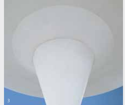
3 Entfernte Rostspuren durch Feinschleifen, Decke
