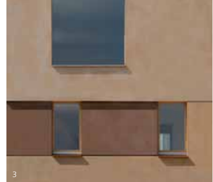
3 Farbige Fertigteile, Büro- und Produktionshalle, München
