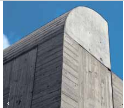
Unterschiedliches Saugverhalten der Schalhaut
