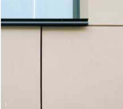
1 Gesäuerte Fertigteile, Bürohaus, Frankfurt
