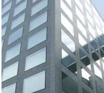
Feingeschliffene Betonwerksteinplatten, Bürohaus, Zürich
