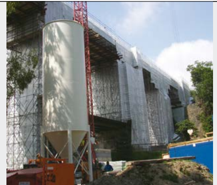
Beton- und Mauerwerkssanierung
