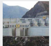
7. Muratlin, Türkei, Hydropower Station, Firstspaltverpressung beim Überlaufstollen
