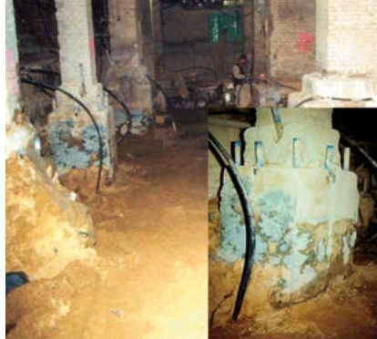
Unterfangungsinjektion Staatsbibliothek Berlin
